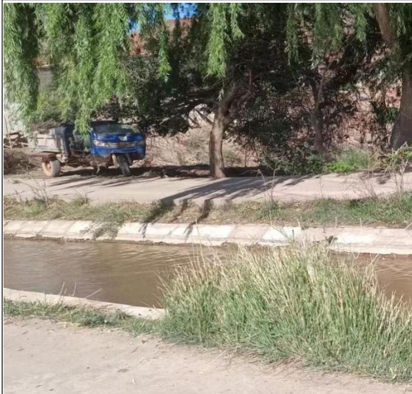
自流干渠现状
