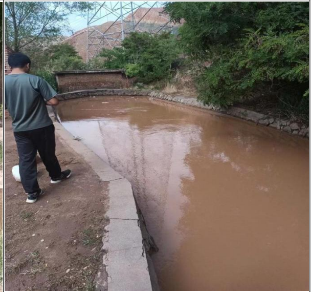
输水管道出口消力池现状
