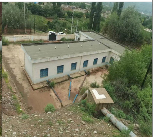
野狐沟二级泵站上水管现状
